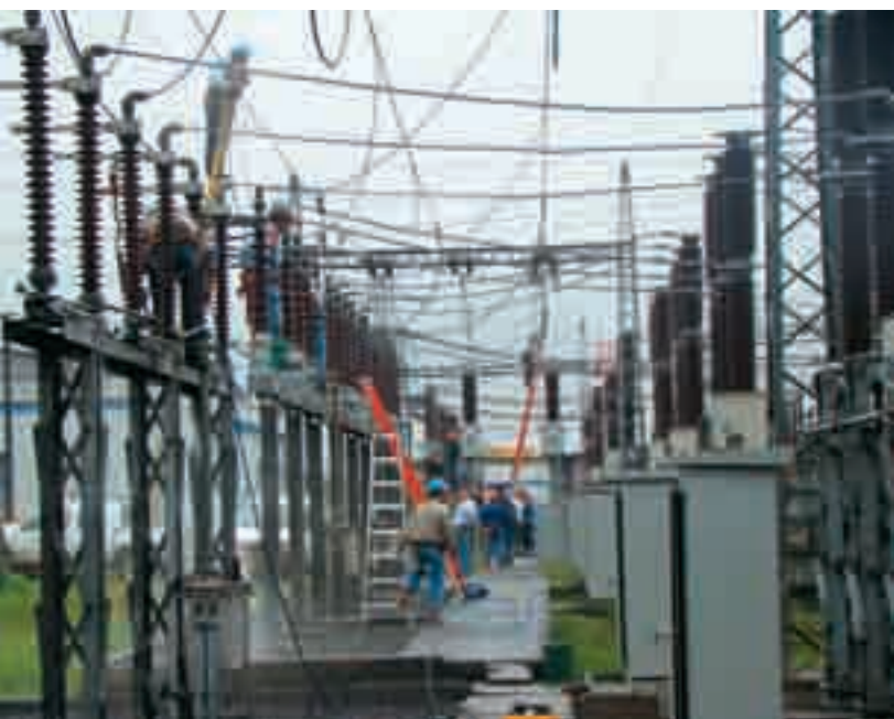
Detalles del mantenimiento realizado en la Subestación Esmeralda 115 kV
