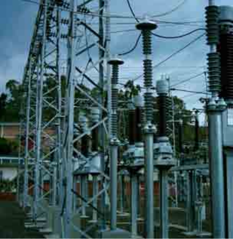
Reposición de interruptores de potencia
